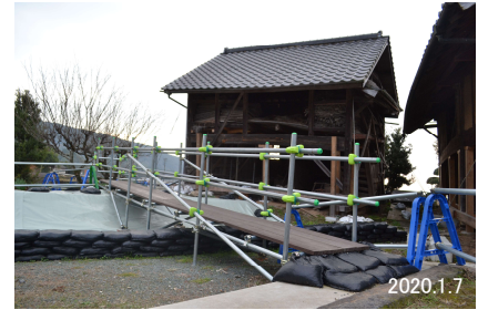
図 5-21 仮設ブリッジ
