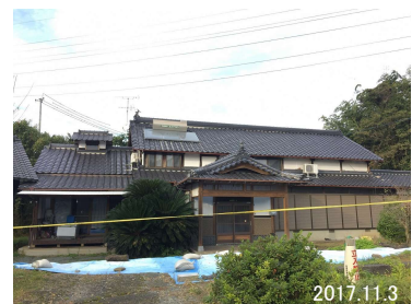
図 5-17 解体前の母屋
