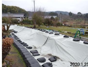
高耐候シートと水防用の土嚢設置
