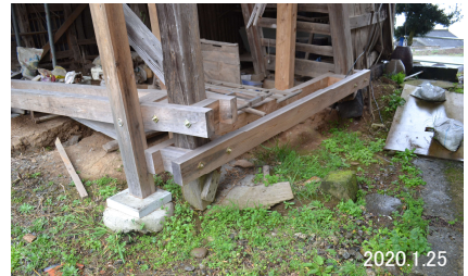
納屋 1 の基礎(保存措置後)
