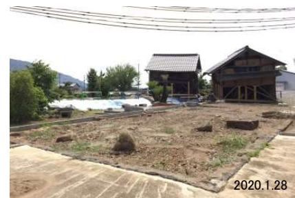
図 5-19 母屋基礎(玄関周辺)
