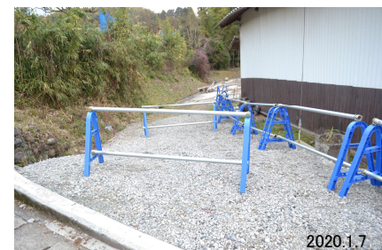
図 5-23 北側法面の水路と仮設道
