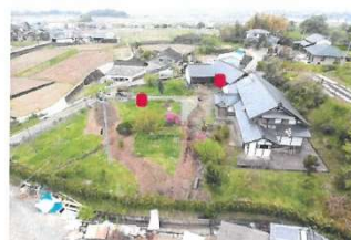
設置箇所(谷川地区:庭/納屋)
