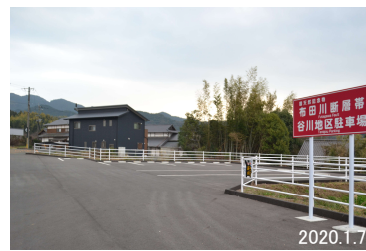
仮設駐車場(谷川地区)
