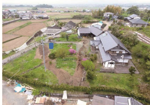
写真 2-2-2 設置箇所(福原地区:庭)
