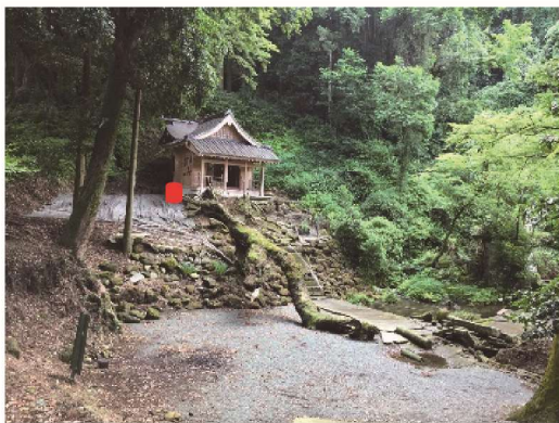
写真 2-1-1 設置箇所（杉堂地区：神社）
