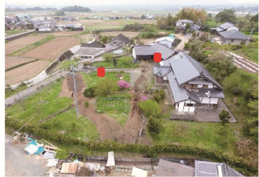
写真 2-1-2 設置箇所（福原地区：庭/納屋）
