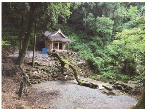
写真 2-2-1 設置箇所(杉堂地区:神社)
