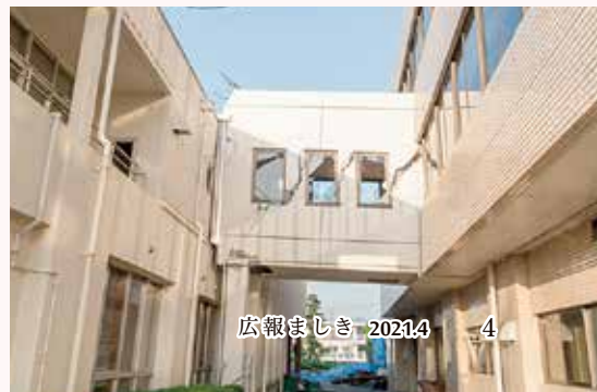
被災した 旧益城町役場庁舎
