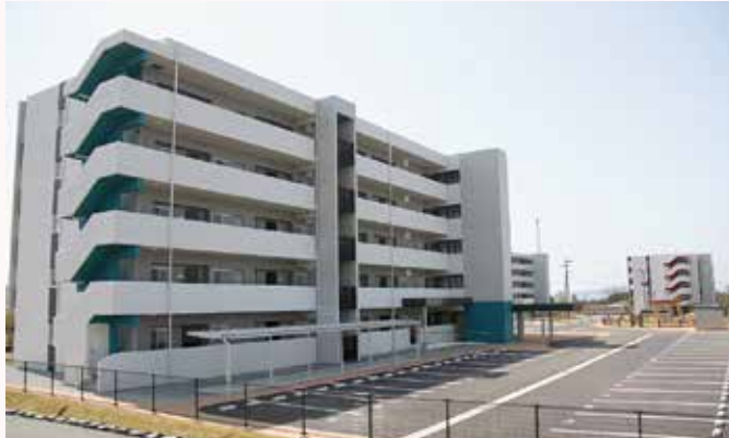
災害公営住宅（下辻団地）
