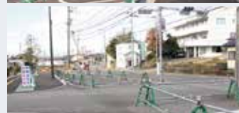
4車線化モデル地区が次々と完成する県道熊本高森線
