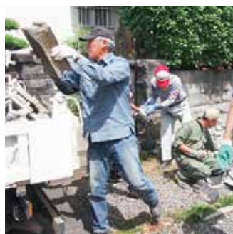
がれきの撤去作業(熊本地震)
