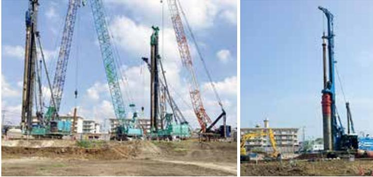
㊦杭工事では、深さ40～50mの支持層■に67本の杭を打設 ㊦6月に
