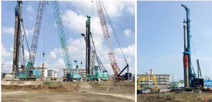
㊦杭工事では、深さ 40 ～ 50m の支持層■に 67 本の杭を打設 ㊦ 6 月に 行った既存杭の引き抜き ■ 建物の重さを支えるのに十分な固さの地層
