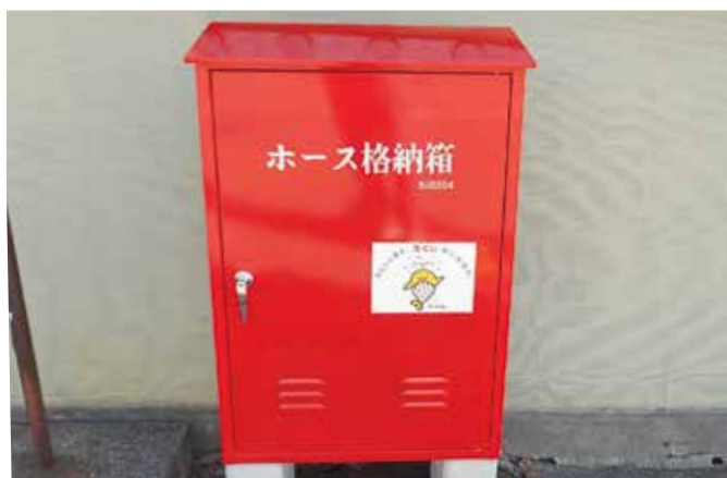
整備された屋外消火栓ホース格納庫
