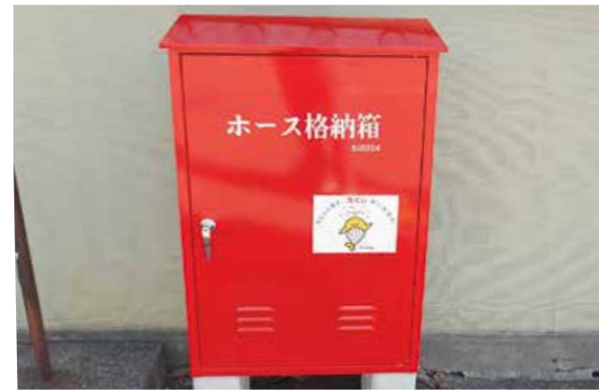
整備された屋外消火栓ホース格納庫
