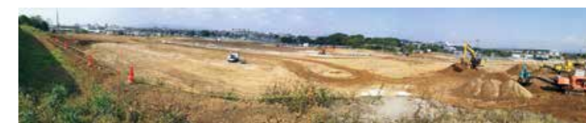
さくら病院の北東(上図)から北に向かって撮影した造成工事の状況(11月初旬)
