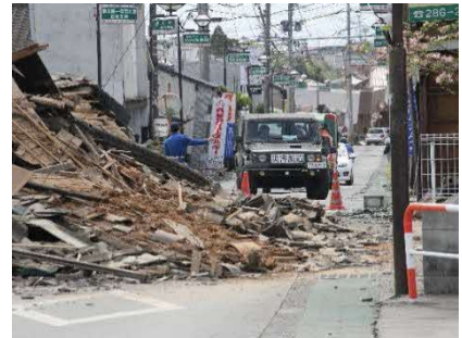
家屋の倒壊と県道熊本高森線の状況
