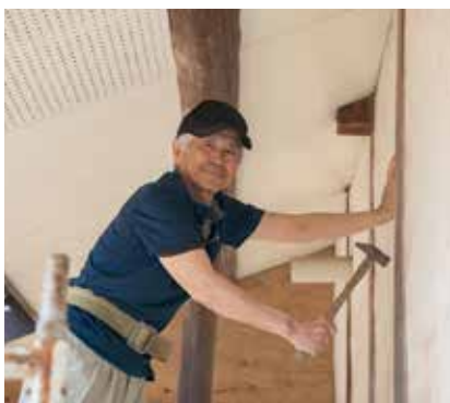
山本さんの補修作業はまだまだ続いています
