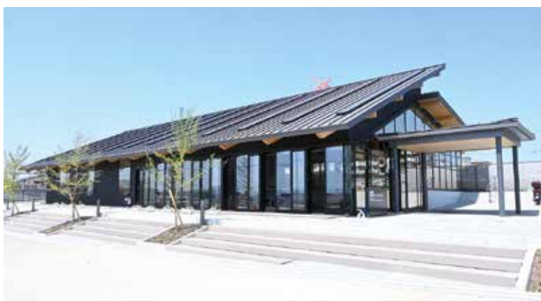
建設工事が進む来年完成予定の新庁舎の南側に今春オープンした「益城町復興まちづくりセンターにじいろ」
