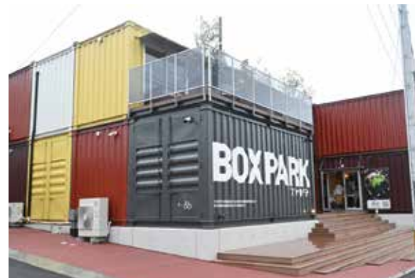
惣領交差点にオープンした、キューブ型のユニークな商業施設「BOX PARK マシキラリ」
