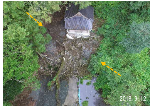
地表地震断層と潮井神社
