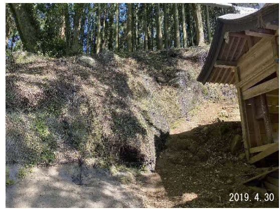
杉堂 社殿裏崖面の落石防止ネット
