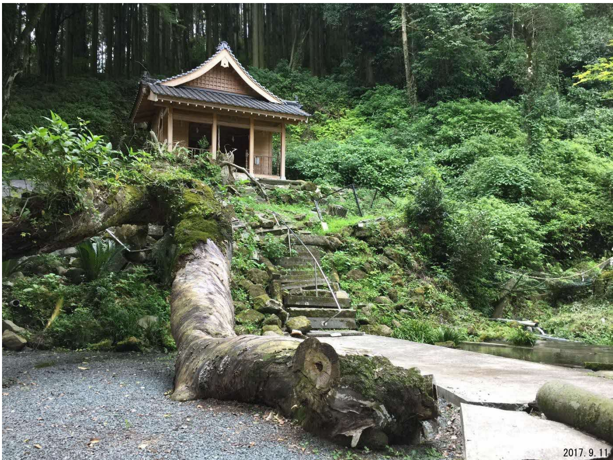
図1-3 潮井神社の地表地震断層による石段のずれと水源（杉堂地区）
