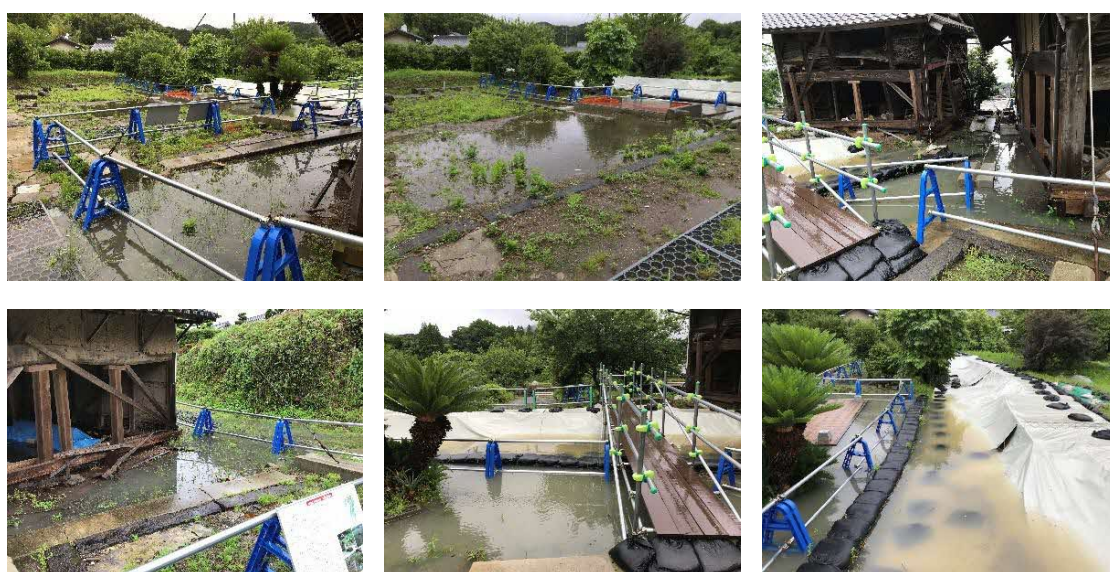
図9-14 大雨時の滞水状況（令和3年5月17日）
