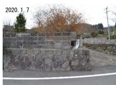
谷川 石垣と擁壁
