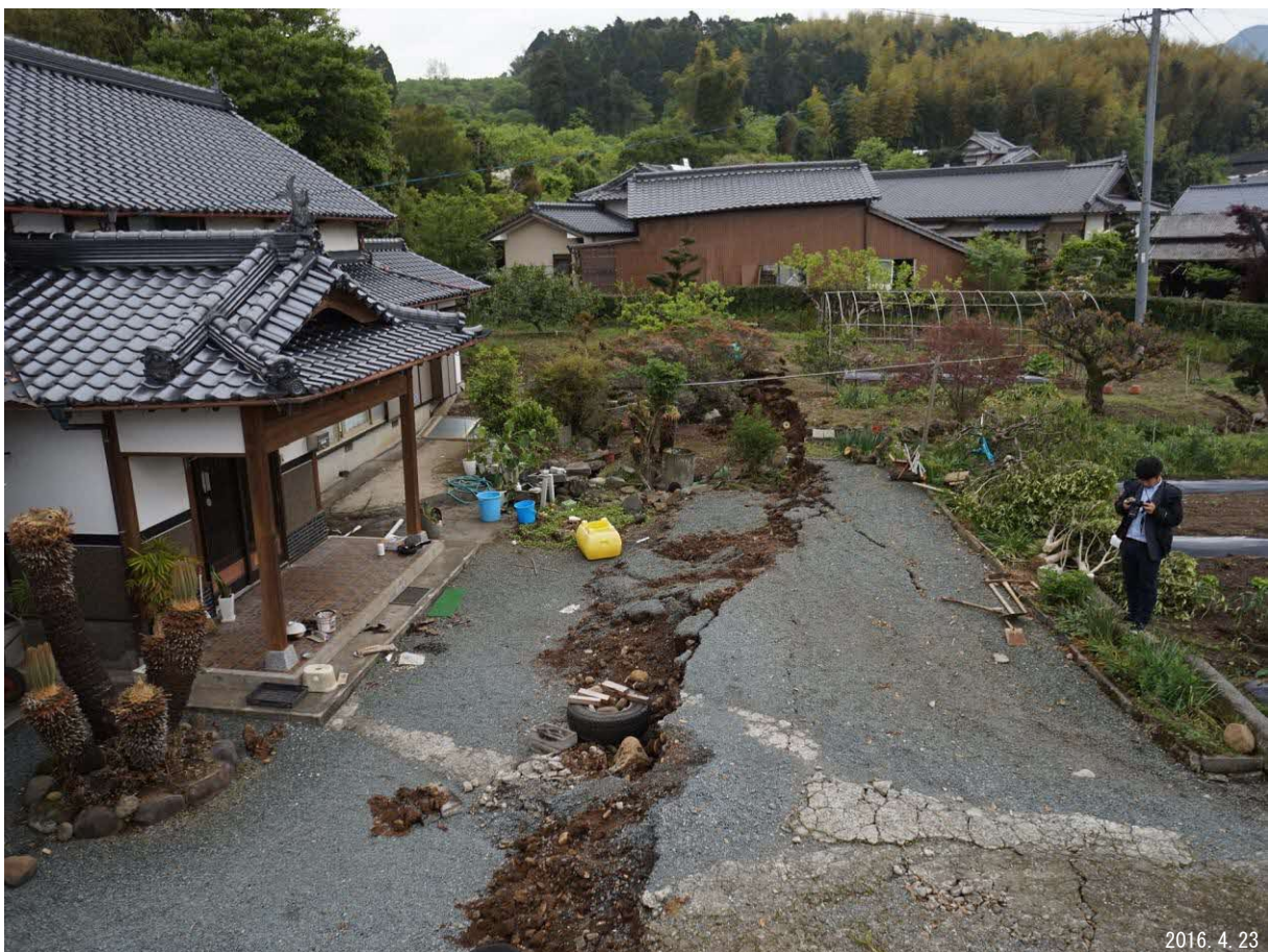
図1-7 民地内に表れた地表地震断層（谷川地区）
