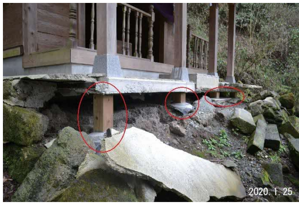
杉堂 社殿の基礎(支柱の設置)
