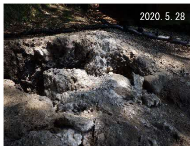
杉堂 シートで覆うことで発生したカビ
