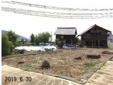
谷川 母屋解体後
