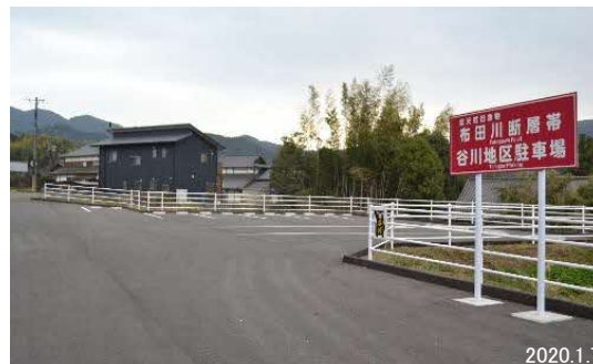
谷川地区駐車場
