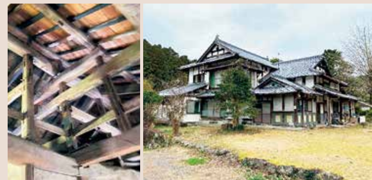
㊦土間から見上げた屋根を支える小屋組み ㊧河端新家住宅外観
