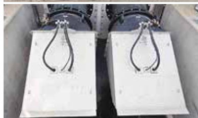
写真上から 安永雨水ポンプ場 福富雨水ポンプ場 場内に設置されている 排水ポンプ
