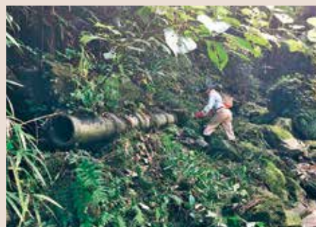
水源から傾斜地に埋設された水道管
