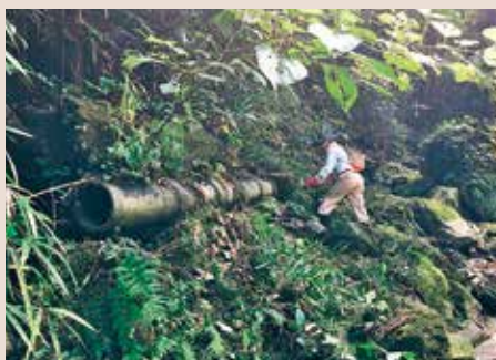
水源から傾斜地に埋設された水道管
