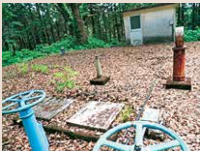
高遊原の水道施設跡
