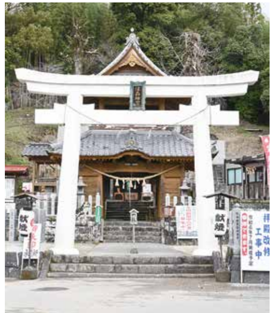
由緒ある津森神宮。奥の拝殿の修復工事が進んでいます
