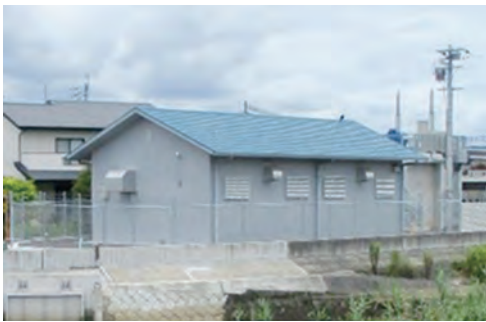
安永雨水ポンプ場
