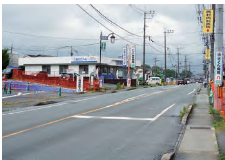
4車線化工事が進む中心市街地（惣領地区）
