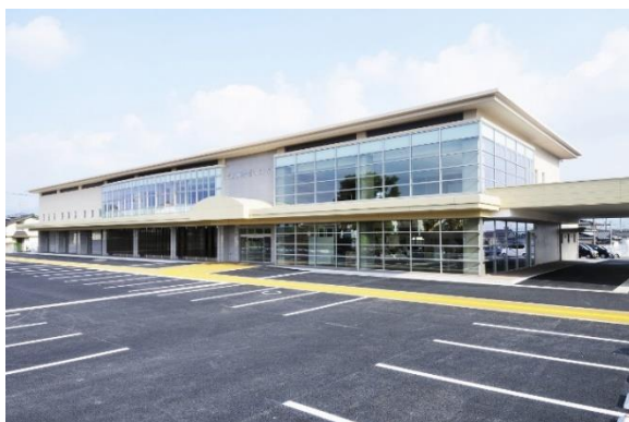
益城町保健福祉センター外観
