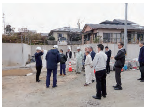
東西線工事確認
