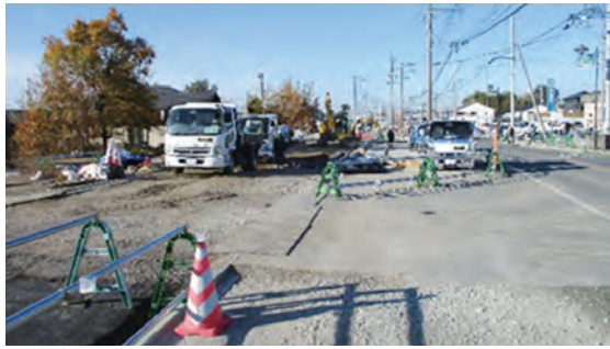
4車線化工事が続く県道熊本高森線
