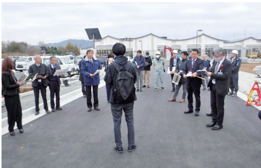
地域共生センターの工事の進捗を確認
