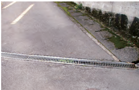
町道を横断するグレーチング
