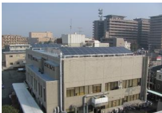
太陽光発電（上下水道局別館） 出典：熊本市
