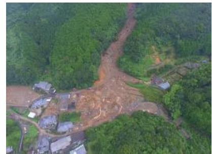
土砂崩れによる斜面崩壊 (津奈木町福浜地区) 出典：熊本県「県内の被害概要 (令和2年7月豪雨)」
