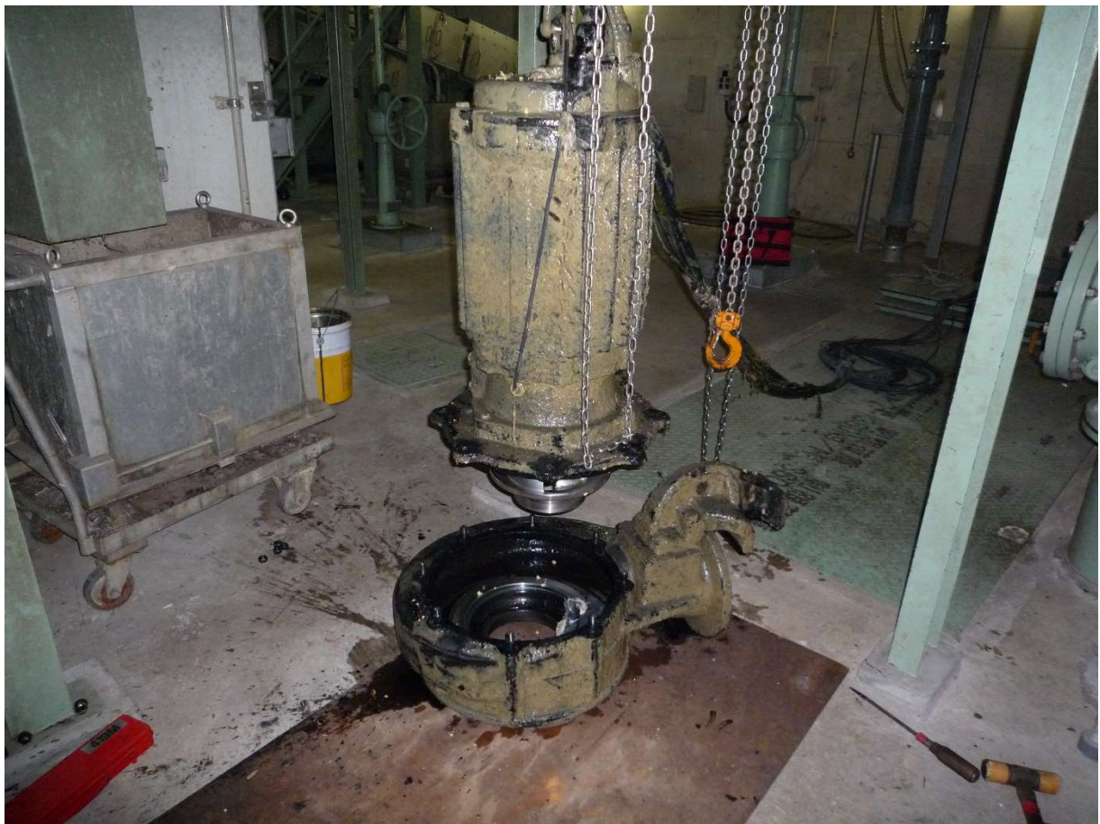
●町浄化センター内における異物混入に伴う部品取り外し
