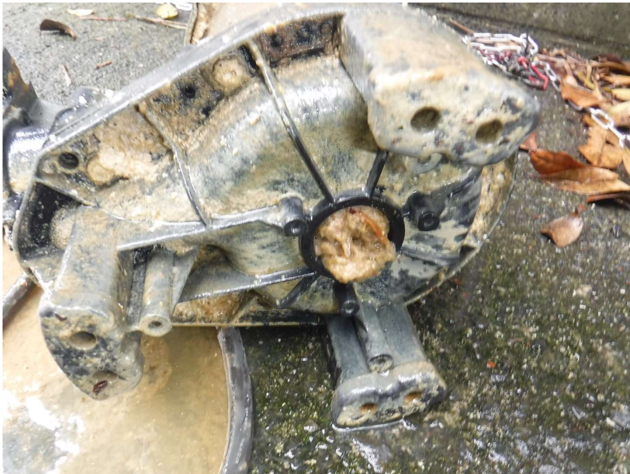
●マンホールポンプ異物混入に伴う部品取り外し
