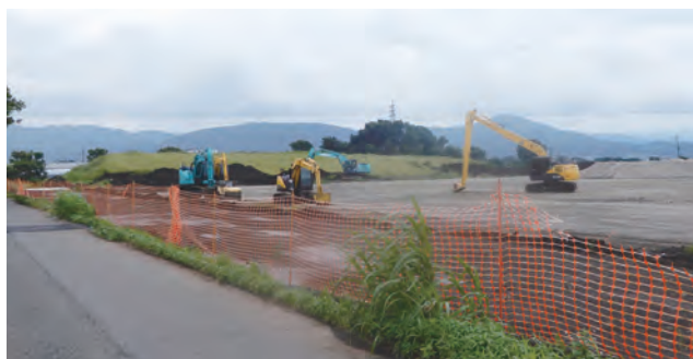
益城インター北産業団地の工事現場
