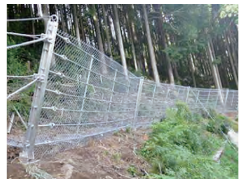
福原袴野線落石対策工事現場
