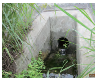
フラップゲートのない水路
