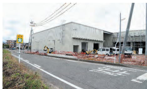
通学路沿いに建設中の商業施設
