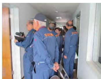
水道センター被害状況視察
