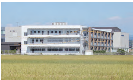
増築された益城中教室
