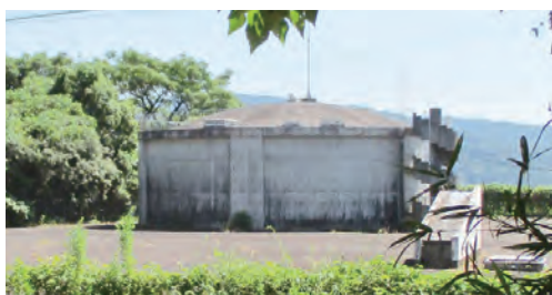
益城町上水道地区第2 PC 配水池
