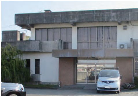
水道センター管理棟 1978年建築
