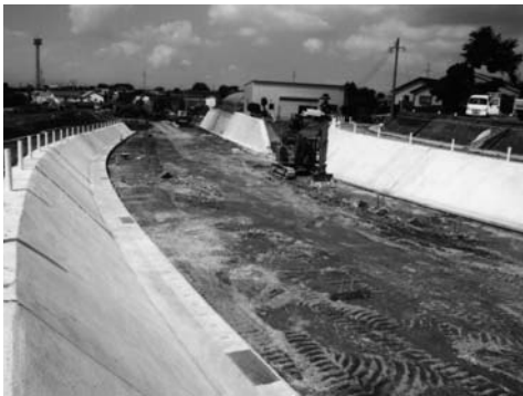
工事が進むグランメッセ木山線
