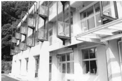
グリーンカーテン用ルーバーを設置した校舎
