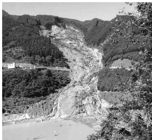
平成23年台風第12号による土砂崩れ(奈良県吉野郡川上村)
