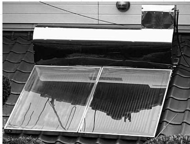
屋根などに設置して太陽の熱エネルギーから温水をつくり、お風呂や給湯に使う装置です。
