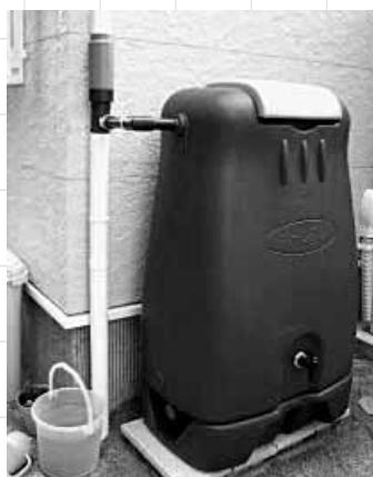
雨水タンクは、屋根に降った雨水を集めて貯めし、その雨水を植木への水やりや打ち水などに使用します。
