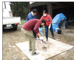
③土、石灰、セメント、水に溶いたがりを混ぜ合わせる
