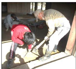
①古い土間の表面を削る
